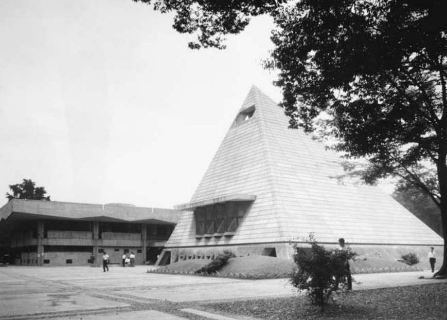
完成した中央教室と(旧)本部長 (昭和35年8月竣工)
