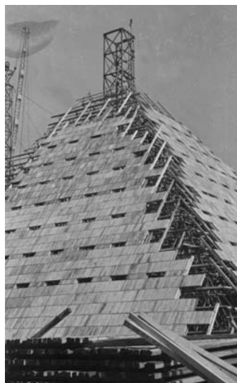
建築途中の中央教室
